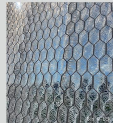
Innenseite des Textils leitet das Wasser nach unten in ein Profilsystem ab. Von dort kann es entweder in einem Reservoir gespeichert oder direkt im Gebäude verwendet werden, um den Wasserverbrauch zu senken. An heißen Tagen wird das Wasser zurück in das Fassadenelement geleitet, wo es verdunsten kann, um Gebäude und
